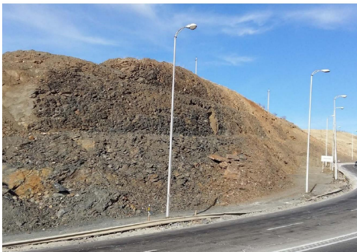
شکل ۱-۱۵۷: توپوگرافی ملایم شیب‌های منطقه مورد مطالعه و احداث ترانشه‌های با شیب تند بر روی آنها کیلومتر ۶+۲۰۰ تا ۶+۳۵۰ از سمت اسدآباد
