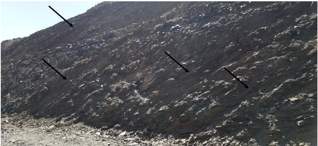
شکل ۱-۱۵۵: حضور پهنه‌های برشی متعدد در ساختگاه ترانشه مورد مطالعه ناشی از تکتونیک پویا منطقه در کیلومتر ۲۰۰+۶ تا ۳۵۰+۶ از سمت اسدآباد
