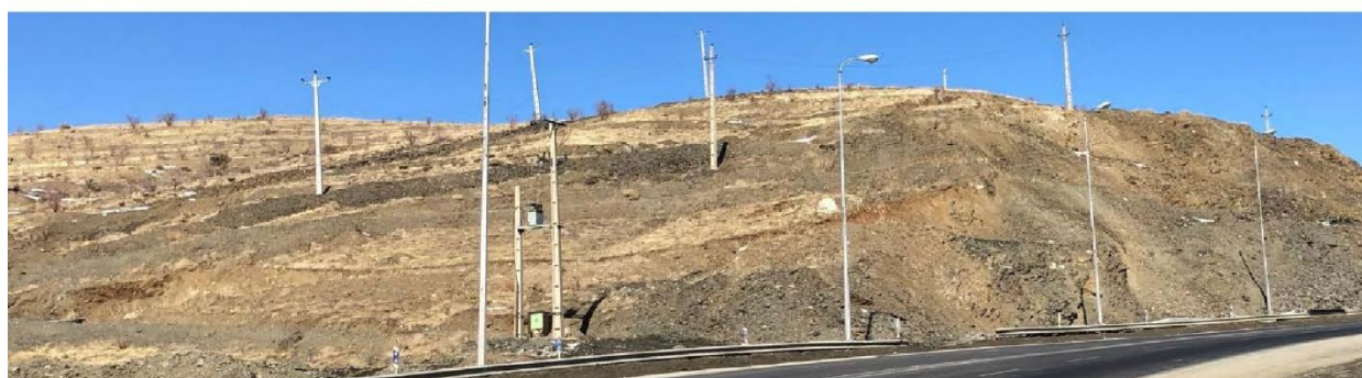
شکل ۱-۱۶۱: شیب ملایم منطقه (در بالا و پایین دست) و از بین رفتن لایه خاک سطحی در اثر احداث ترانشه‌ها
