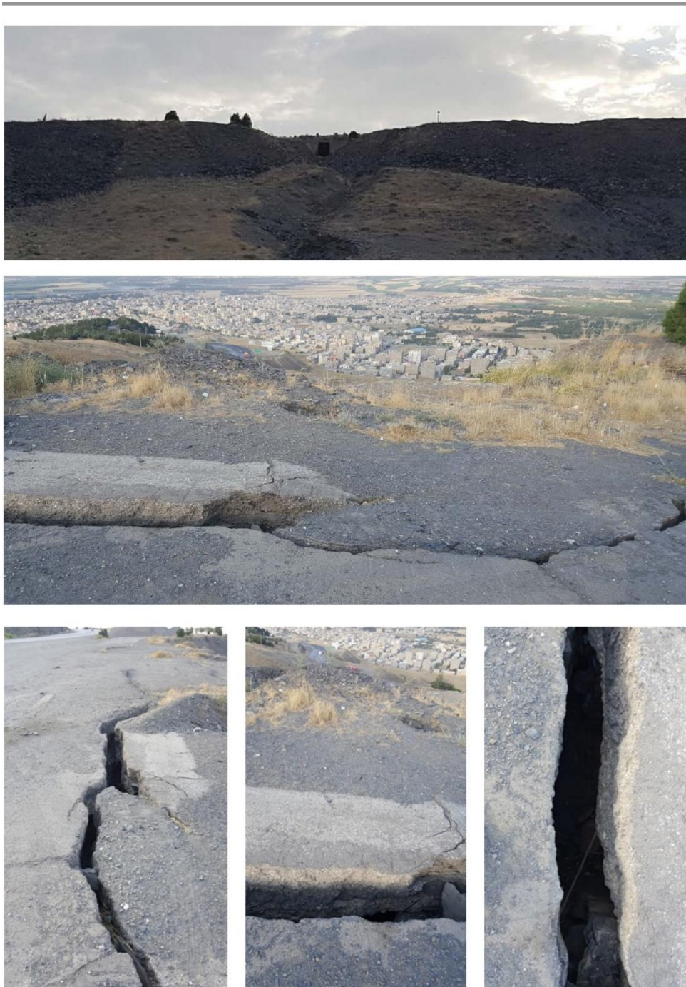
شکل ۱-۱۶۴: تغییر مکان اطراف آبراه و خرابی بستر راه در کیلومتر حدود ۳۵۰+۱ از سمت اسدآباد
